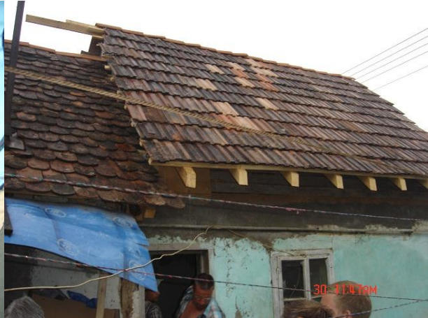
Het nieuwe dak aan de buitenkant
